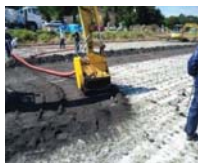
固化剤を用いた削り取り
