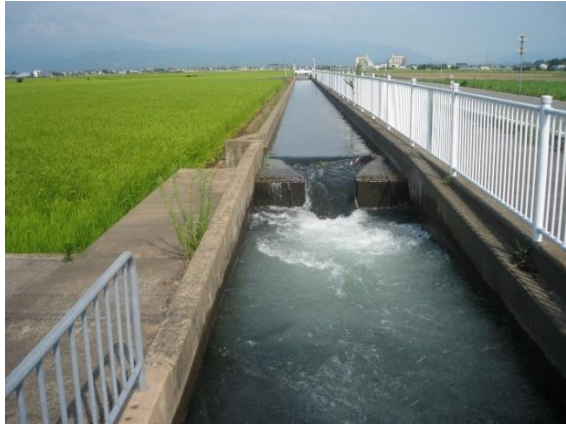
北海幹線水路の状況
