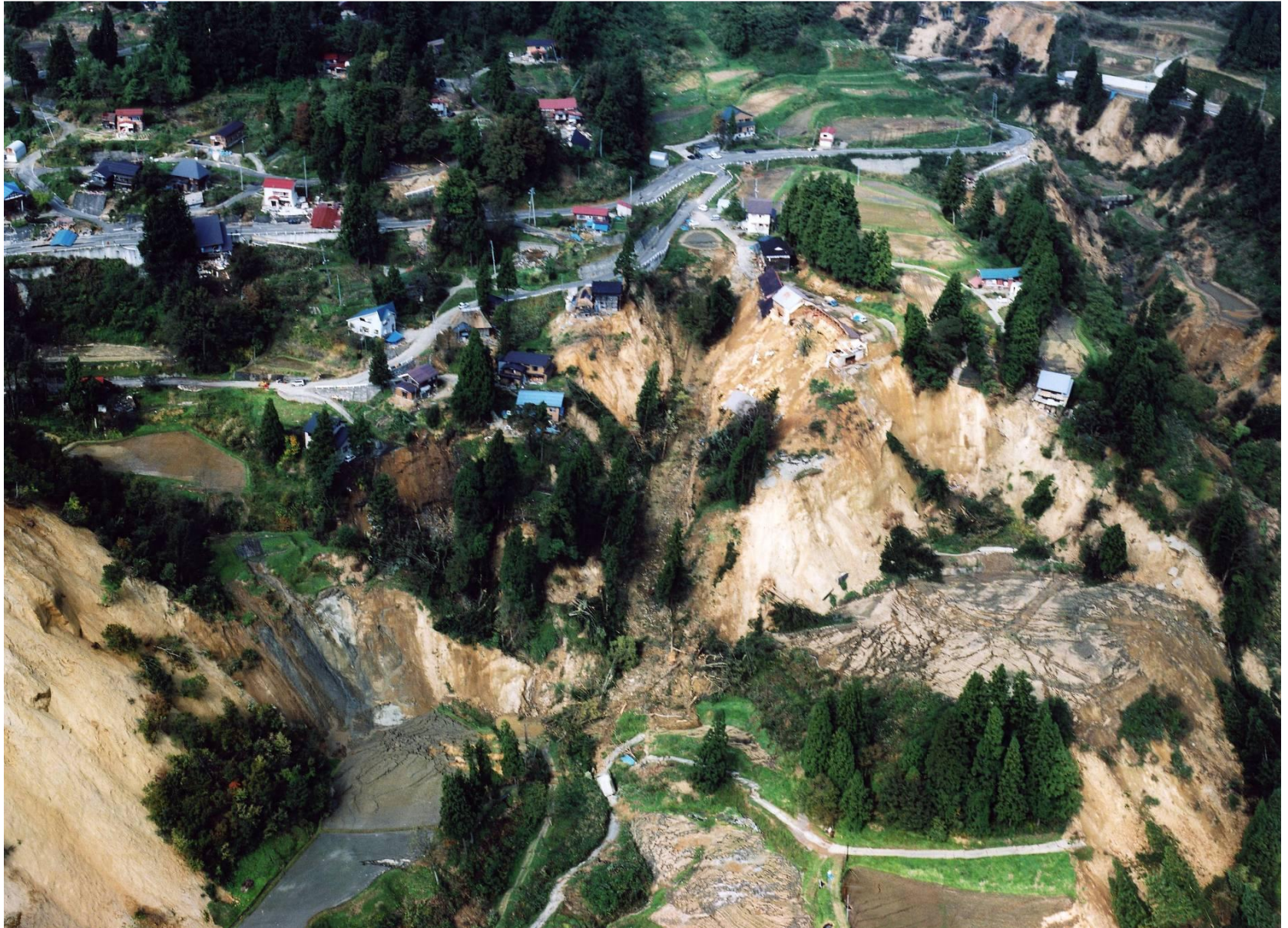
旧山古志村大字南平地内で大規模な山腹崩壊が発生
