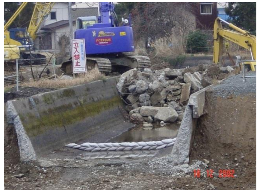
改修中の開水路
