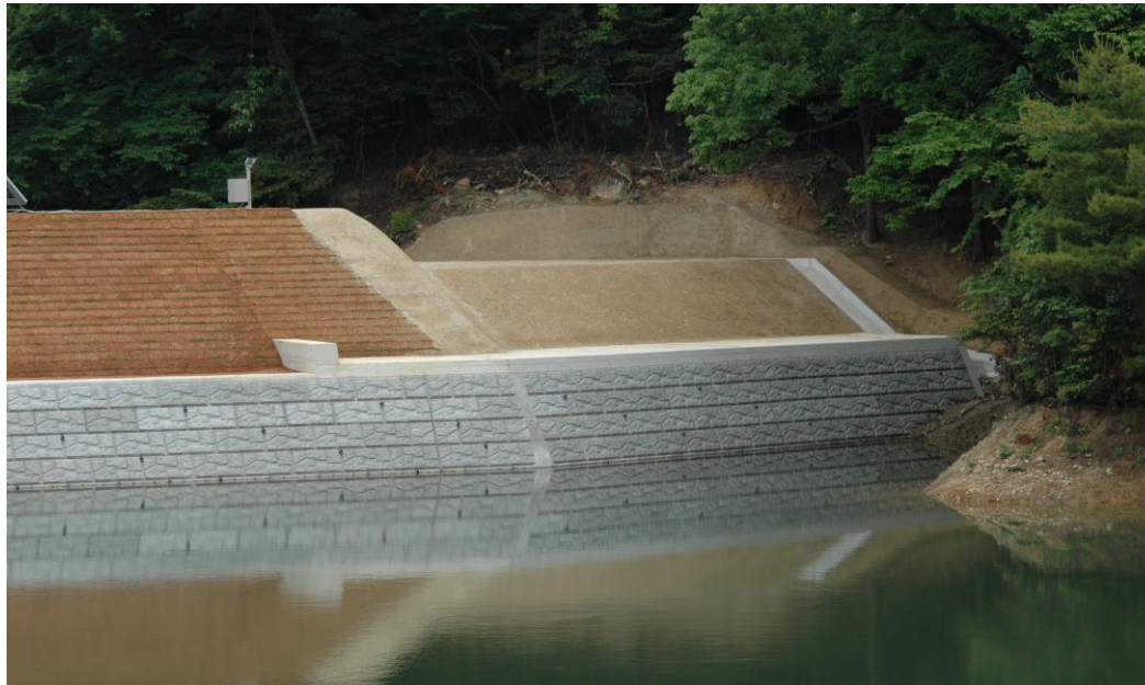
ソイルセメントで覆土して完成
