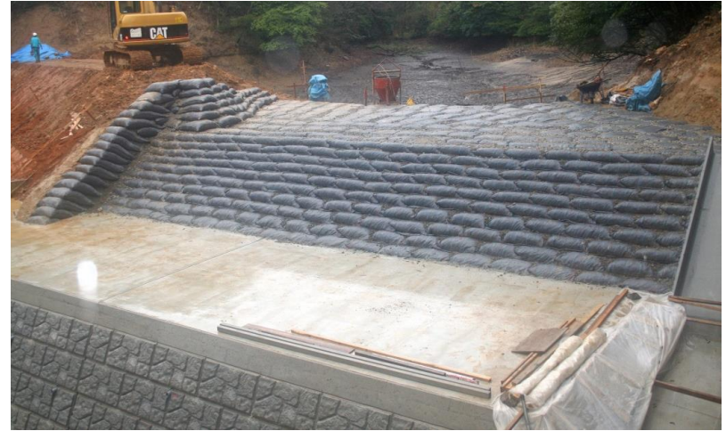
土のうを積み上げた堤体
