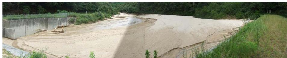
図2 長尾池の状況（貯水池は完全に土石流で埋まるが安全性は確保）
