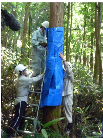
写真 2-8 伐採時の汚染防止のための養生
