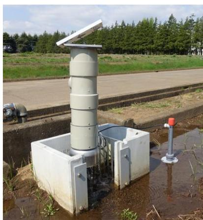
ICTによる遠隔モニタリングにより、給水バルブ・落水口を遠隔・自動制御できる。
