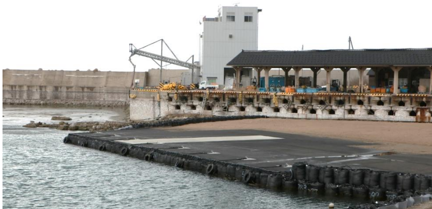
写真5 鹿磯漁港の仮設岸壁（2025 年 3 月、輪島市）
