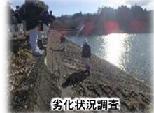
劣化状況調査
