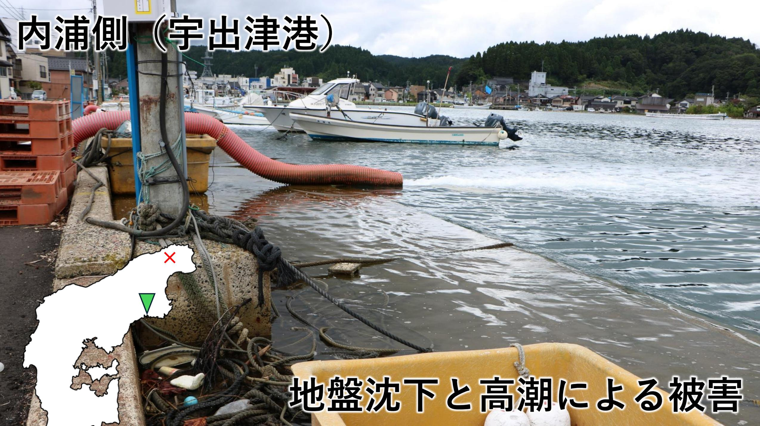
地盤沈下と高潮による被害
