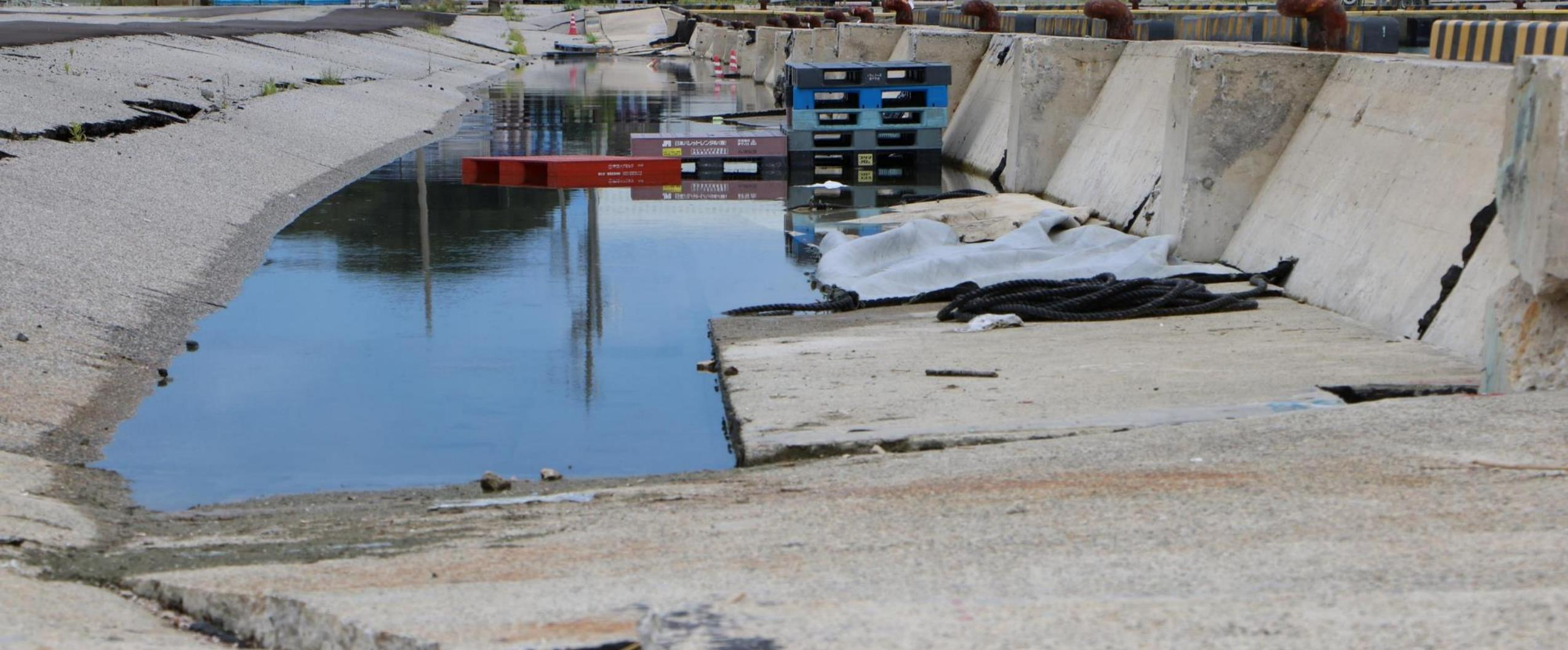
護岸の崩壊・荷揚場のアクセス遮断
