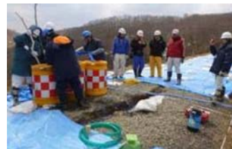
■亀裂深度の探査 電気探査による亀裂深度の調査
