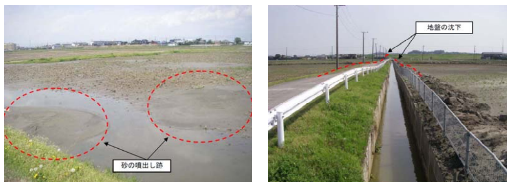
写真2 利根川下流沿岸域（茨城県）での農地等の液状化と地盤沈下による被害（2011.4）
