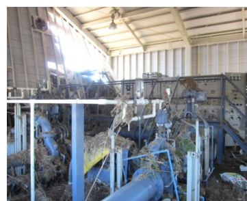
(e) 揚水機場内の状況
