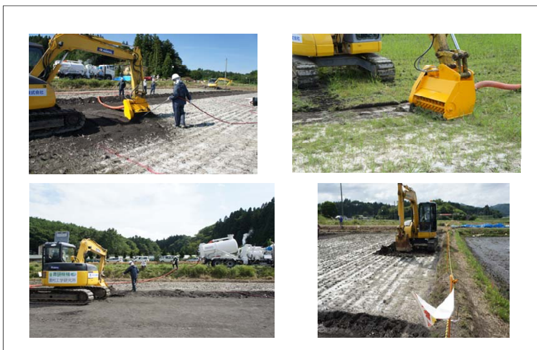
写真7 マグネシア系固化剤施用表土の剥ぎ取り状況 (平成23年8月30-31日)
